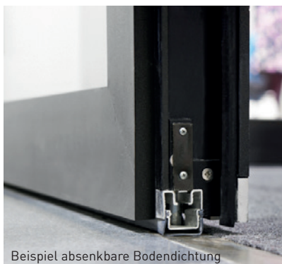
Beispiel absenkbare Bodendichtung
